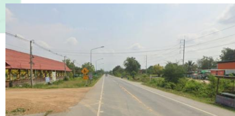
7 ทางหลวงชนบท กจ.3021
